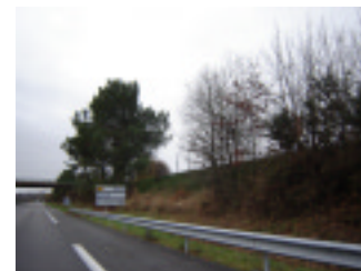
6- Vues fermées (terrains en surplomb / RN - rideau végétal dense) hormis 2 ouvertures
