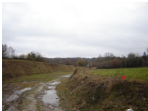
Vue depuis les terrains Nord : merlon non planté récemment créé à l'arrière du talus de la RN. RN visible au point bas.
