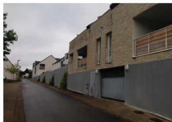
Logement intermédiaire – Surzur (56) Profitant de la pente, le stationnement est clos et semi enterré.
