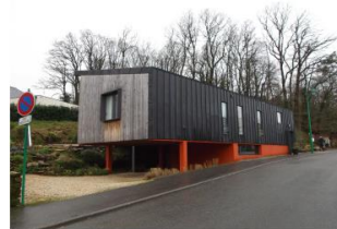
Monterblanc (56) Maison individuelle avec stationnement semi-enterré tenant compte de la topographie du site.
