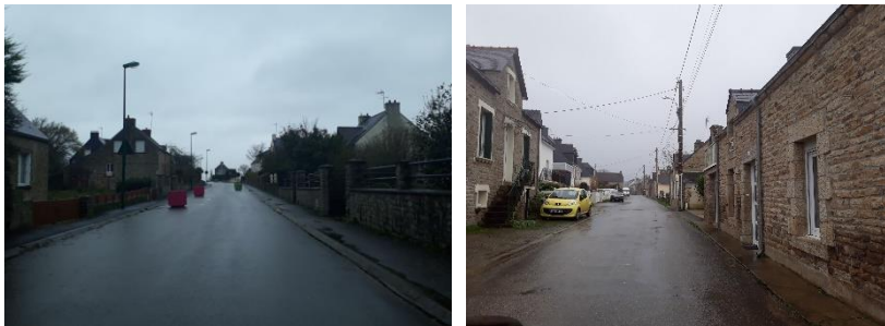
Vue sur les rues bordant le site : la rue des écoles à l'est et la rue Verte au nord
