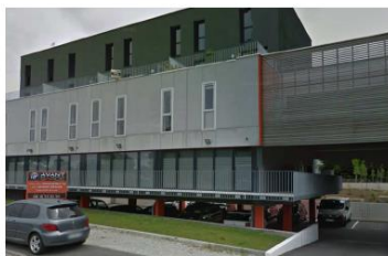
Logement Collectif et bureau – Auray (56) Profitant de la pente, le stationnement se fait de manière semi enterrée tout en étant ouvert.
