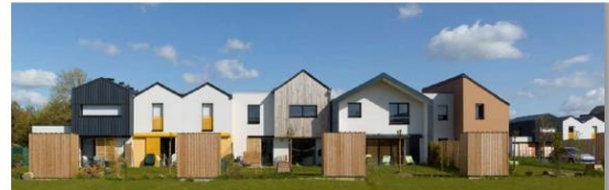
Opération groupée « Vert Buisson » à Bruz (35)
