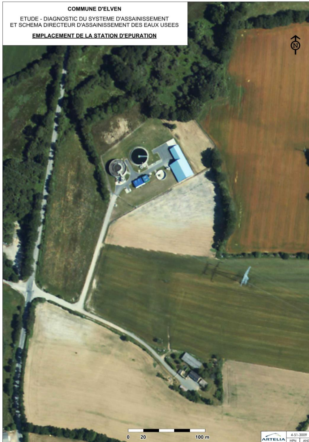
Fig. 8. Photo aérienne de la station d'épuration d'ELVEN
