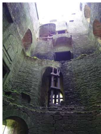
Ci-dessus : vue générale ouest de la forteresse Ci-contre : vue intérieure du donjon et des étaies placés aux 1 er et 3 e étages
