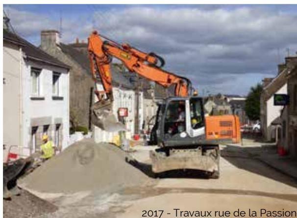
En 2017, les travaux ont commencé par le renouvellement des réseaux d'eaux usées et d'adduction en eau potable avenue de Largoët et rue de la Passion, suivi des travaux d'effacement des réseaux de téléphone, d'électricité et d'éclairage public.
