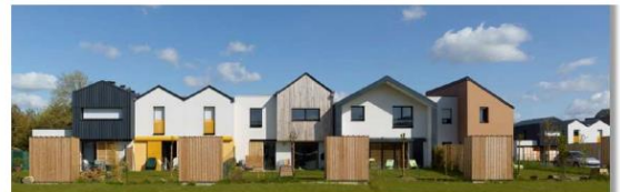
Opération groupée « Vert Buisson » à Bruz (35)
