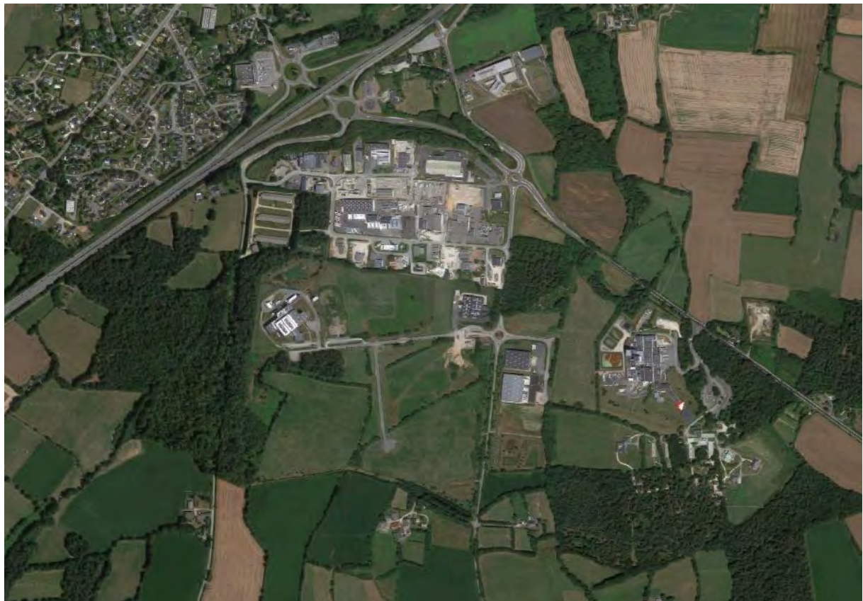
Vue aérienne des espaces d'activités (Source : Google earth)
