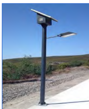
FIGURE 77 : ECLAIRAGE A L'ENERGIE SOLAIRE
