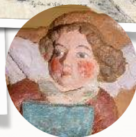
Détail des sablières
